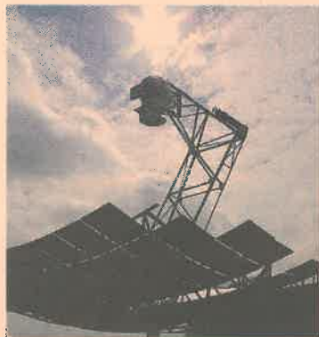
Solkraftverk i Malmö drivet av en stirlingmotor som bygger på Kockums teknik. FOTO: JOHAN NILSSON/TT
