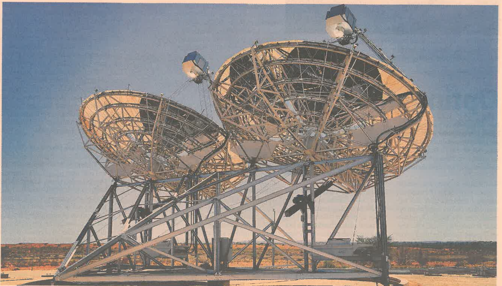
I nordvästra Sydafrika inte långt från den namibiska gränsen står fyra solfångare som ägs av svenska Ripasso Energy. Med hjälp av stirlingmotorer på 25 kilowatt utvinns dessa solkraftverk förnybar energi helt utan utsläpp. FOTO: RIPASSO ENERGY
